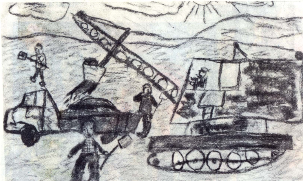
Будет новый канал
